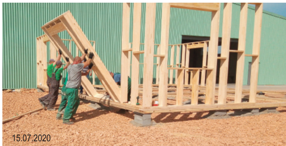
Ręczny montaż elementów. Na budowie elementy do montażu podaje dźwig.
