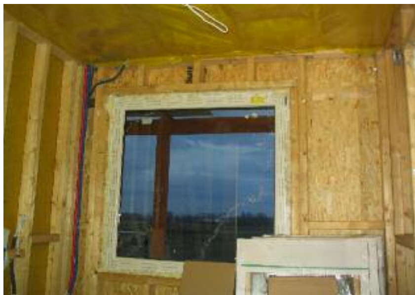
Powyżej przykład niechlujnego ocieplania ścian zewnętrznych. Przykłady tzw. mostków cieplnych.
