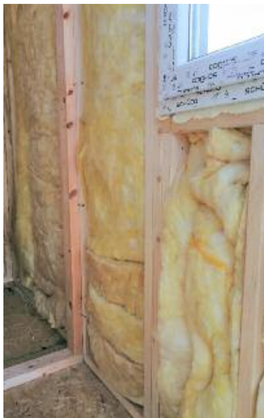
Powyżej przykład niechlujnego ocieplania ścian zewnętrznych. Przykłady tzw. mostków cieplnych.
